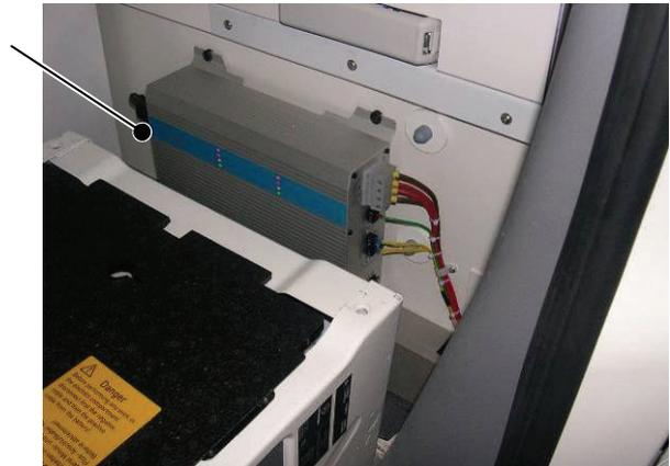
**Achtung!** Die Belüftungsöffnungen des Ladegeräts dürfen nicht verschlossen werden.
