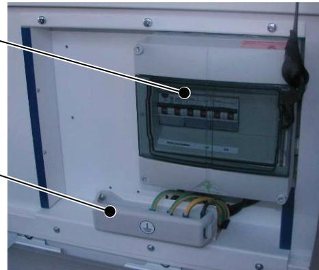
Der Hauptschalter sichert das Netz im Fahrzeug gegen Fehlerströme größer 30mA und die Sicherungsautomaten C3 (4A) und C4 (2A) gegen Überlast bzw. Kurzschluss.
