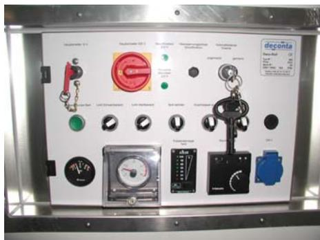
Bild 6: Schaltkasten mit Schlüsselschalter
